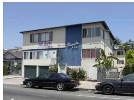
234 S NORMANDIE AVE Los Angeles, CA 90004
